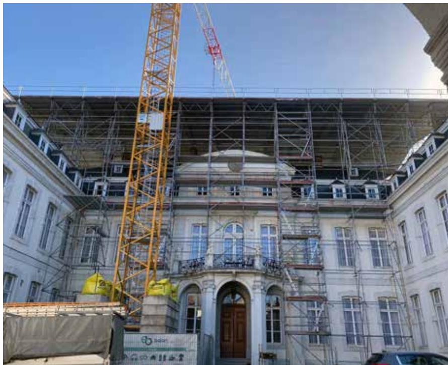
Placement de l'échafaudage et de la toiture provisoire sur l'aile principale en première phase du chantier. © A. Brismé
