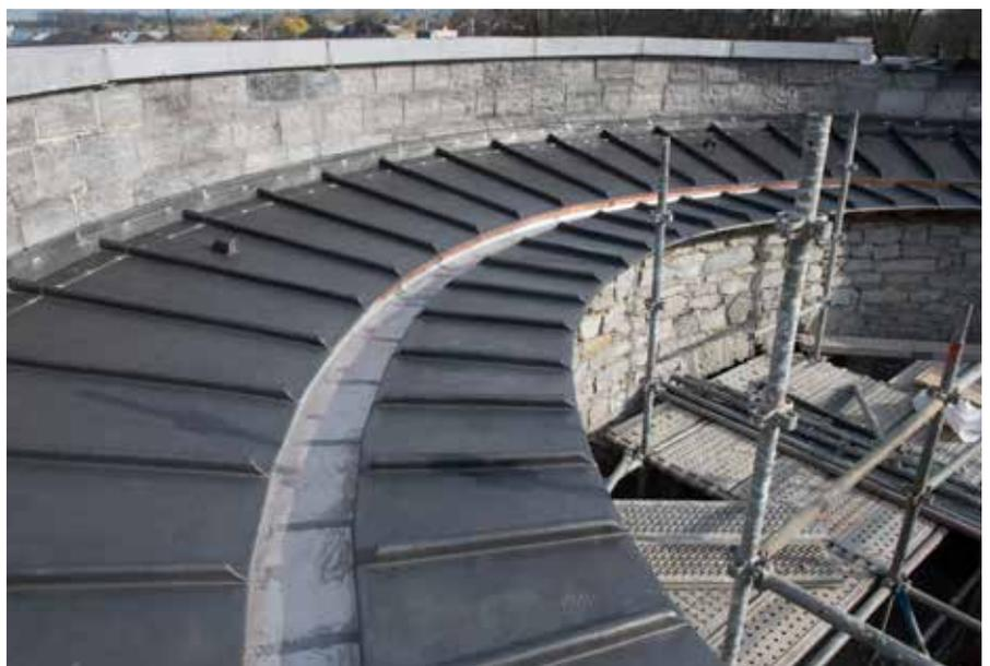
Vue de la partie la plus cintrée, côté aval, avec son chéneau encaissé en Inox AME et un « passe corde » permettant d'assurer la parfaite ventilation du complexe soutenant les tables de plomb.
